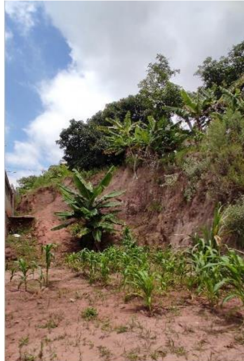
Figura 83 - Talude desprovido de cobertura vegetal suscetível a agentes erosivos. (Fonte: FUNDAG)
