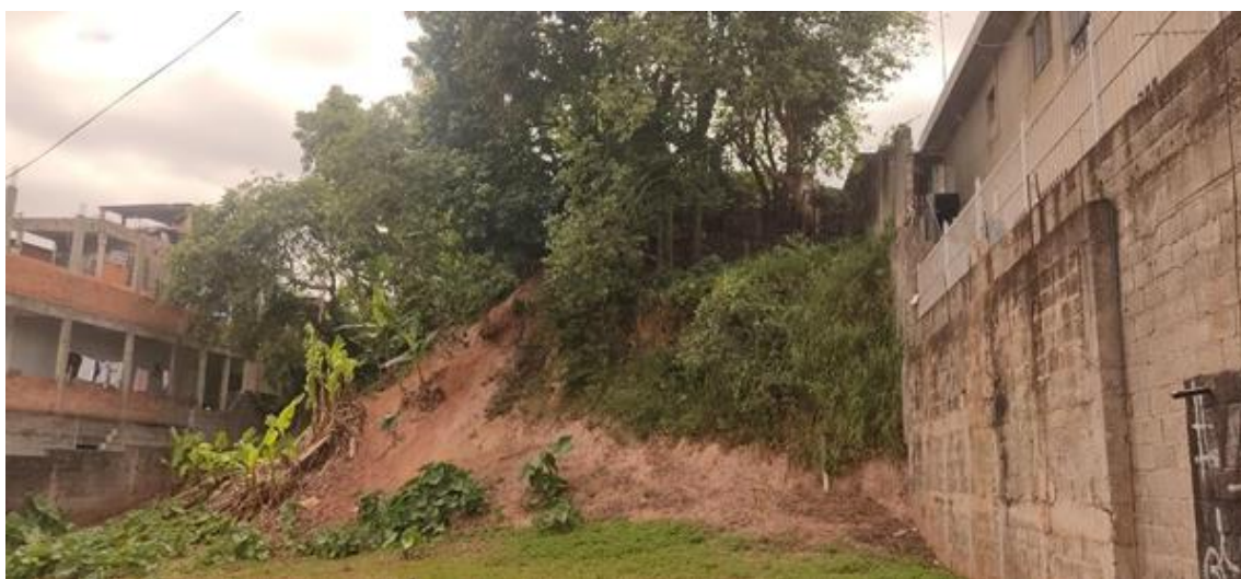
Figura 65 - Ausência de vegetação no pé e em partes do talude. (Fonte: FUNDAG)
